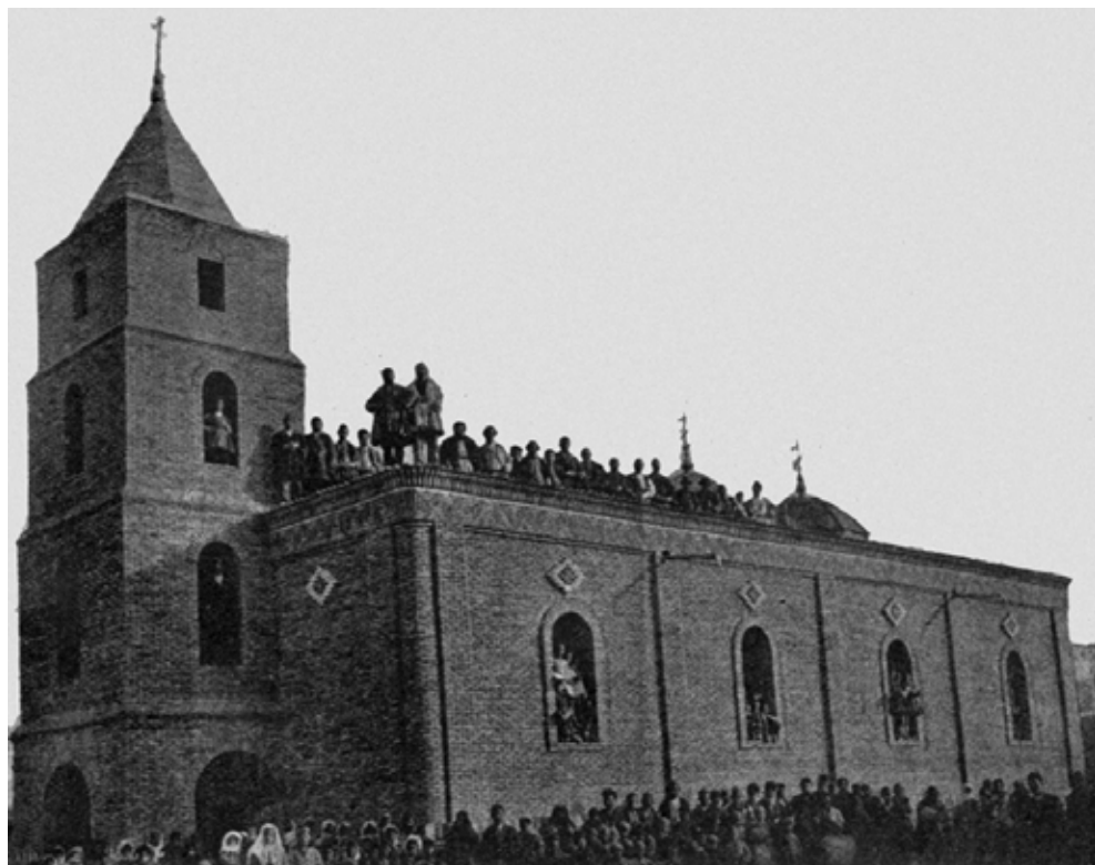
Ил. 5. Новосооружаемая в г. Урмия церковь во имя св. Иоанна Предтечи
